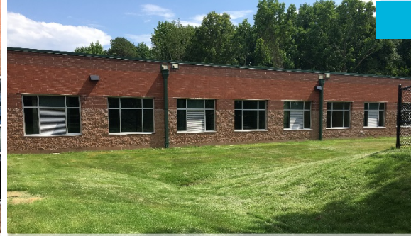
Morris Berg Architects
